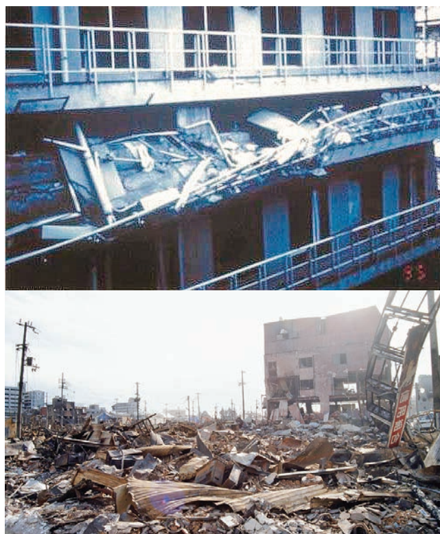
図4 崩壊した西市民病院(周辺は火の海)
